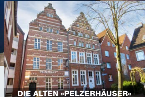
DIE ALTEN »PELZERHÄUSER«
